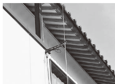
外部アンテナ
