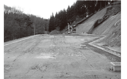
▲飯豊地区仮置場敷地造成工事の様子
