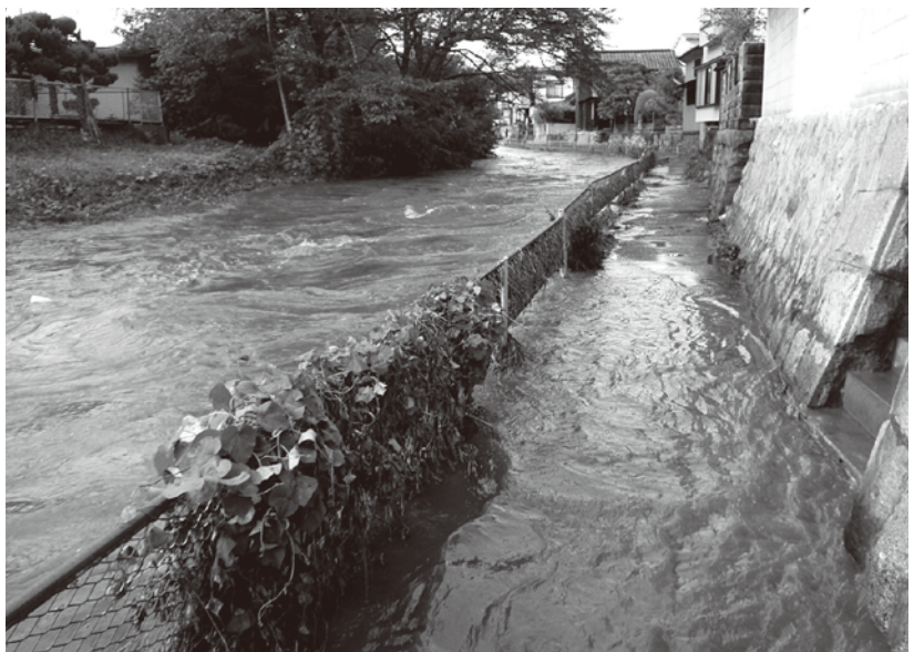
▲増水する右支夏井川(平成25年9月の降雨時・荒町地内)
