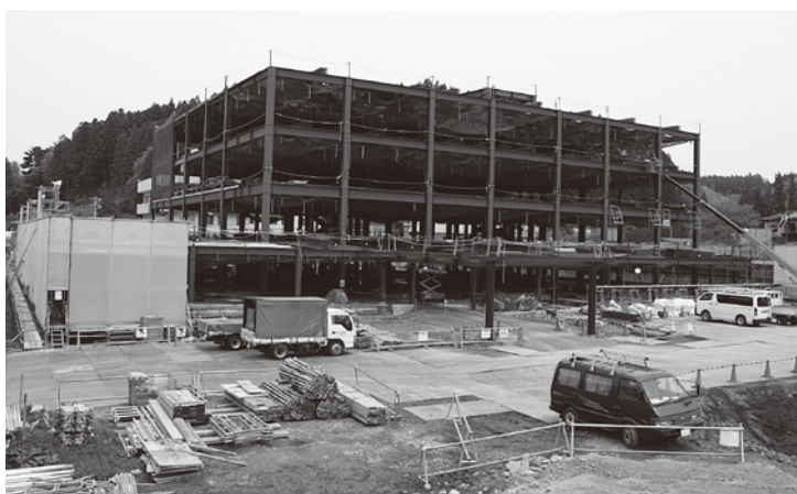
▲新築工事中の公立小野町地方総合病院
