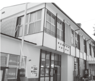
▲建築から53年が経過する役場庁舎
