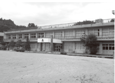
▲廃校となった夏井第二小学校
