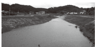
▲河川改修の進んだ平館橋下流
