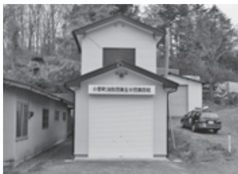
浮金ポンプ置場
