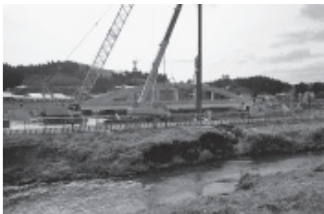
右支夏井川河川改修
