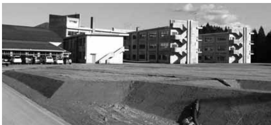
▲改築に向け造成工事が完了した小野中学校 (国道349号線から見た小野中学校)
