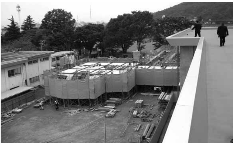
▲解体と建築を繰り返す福島市立福島第三中学校
