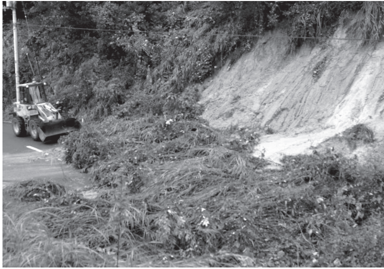
塩庭地内の法面崩落現場（県道平田小野線）
