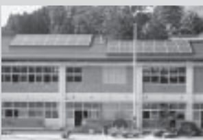
太陽光発電設備工事が完了した夏井第一小学校(上)と浮金中学校(下)
