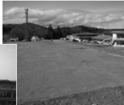
施工前の様子
