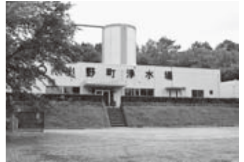
小野町浄水場
