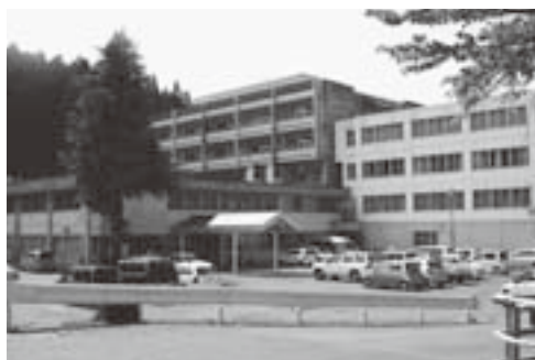
公立小野町地方総合病院
