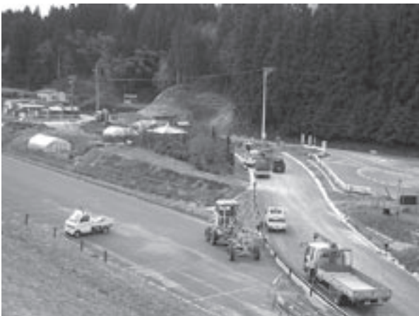
町道七生根線改良工事
