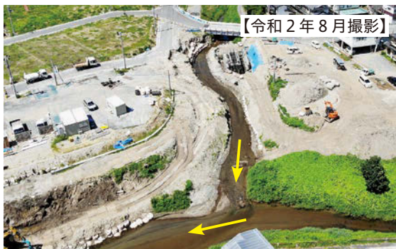
写真1 - 車川合流付近の施工中状況
