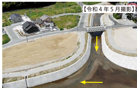
写真2 - 車川合流付近の竣工状況
