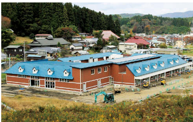
建設中の園舎の様子(11月1日現在)
