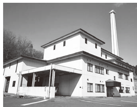
田村東部環境センター (ごみを処理する施設)
