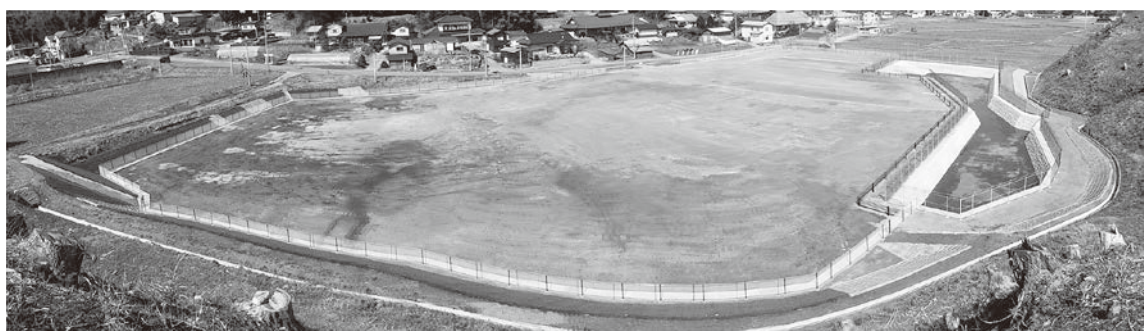
敷地造成工事が完了
