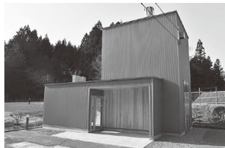
完成したペット火葬場
