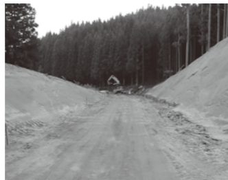
▲小野新町地区仮置場進入路整備工事(3・4工区)の様子
