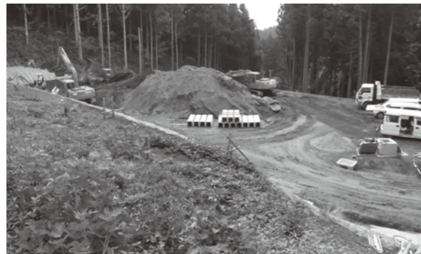
▲小野新町地区仮置場敷地造成工事の様子
