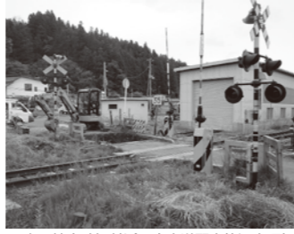
▲鬼石地内踏切付近の上水道配水管漏水現場
