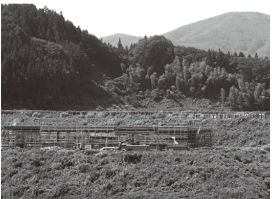
▲建設工事が進む(株)三宝製作所の工場
