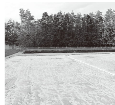
今年の6月に完成した夏井地区仮置場
