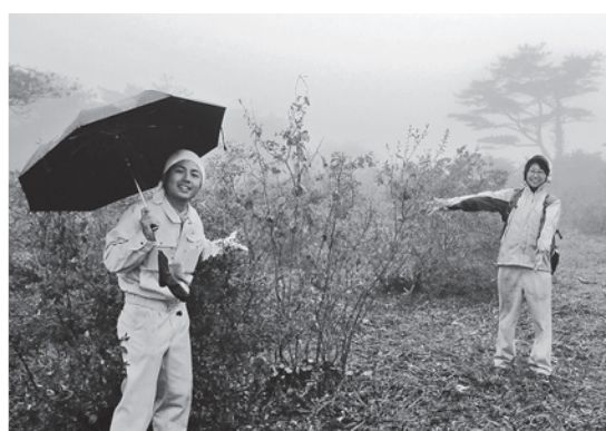
作業後の様子 すっきりしました！
