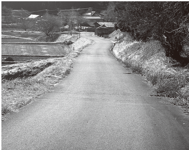
▲小野新町地区仮置場への進入路として使用が予定されている町道大倉線
