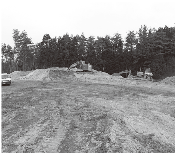
▲夏井の仮置場造成状況
