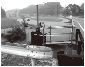
▲平成25年の台風18号による吉野辺字開場地内の増水状況
