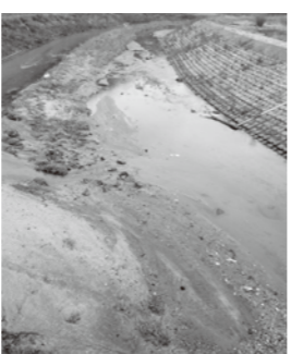
▲河川改修が進められる右支夏井川
