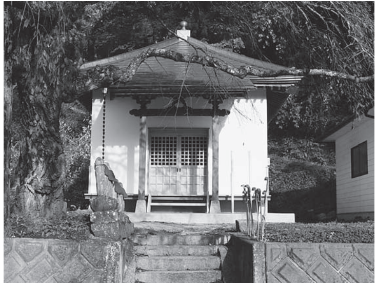
全面改修工事が完了した湯沢・来迎寺地藏堂
