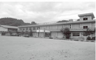
▲廃校となった夏井第二小学校
