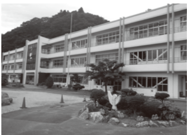
▲耐震補強工事の済んだ小野新町小学校
