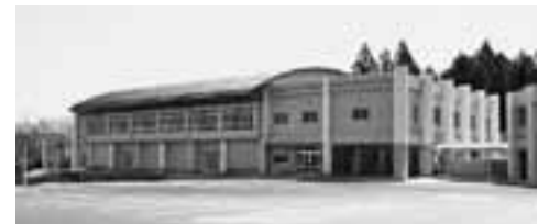
小野中学校屋内運動場
