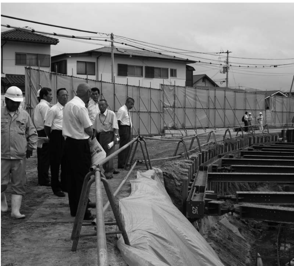
▲中心市街地での河川改修を視察(愛媛県今治市)
