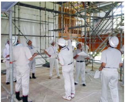
▲耐震工事施工中の体育館(夏井第一小学校)
