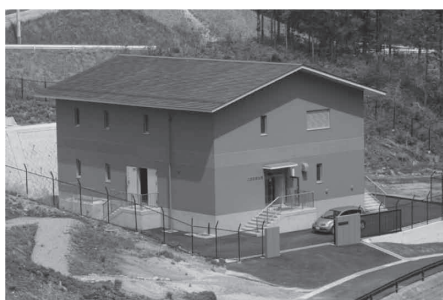
竣工したこまち浄水場
