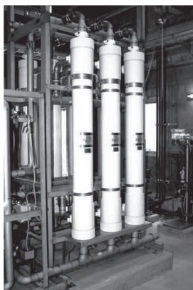
膜ろ過処理設備
