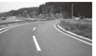
整備が進む町道七根線
