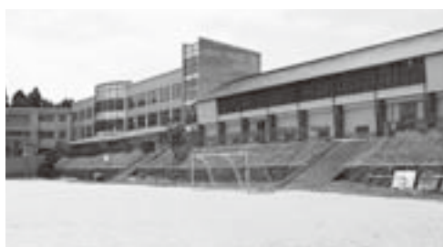
耐震診断が実施される小野中学校
