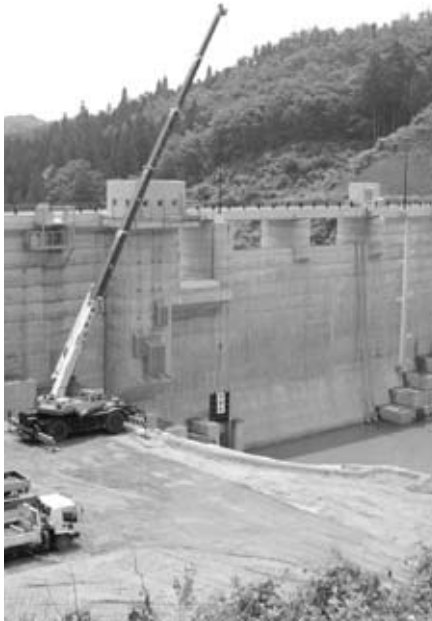
完成したダム堤体
