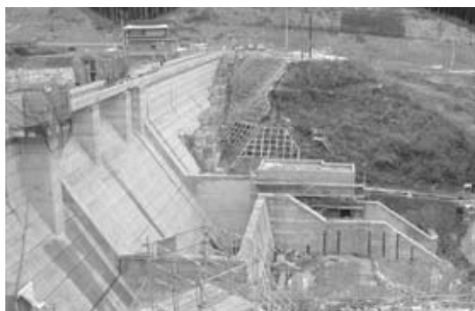
平成19年3月の完成を目指して 工事が進むこまちダム
