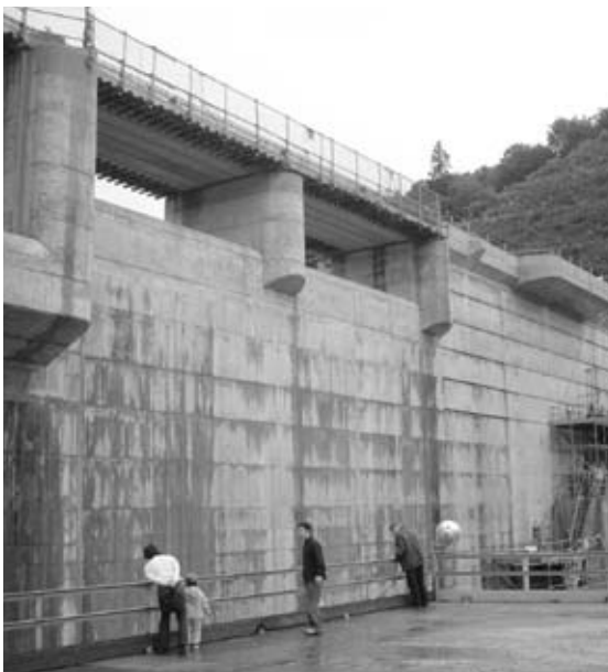
建設が進むこまちダム
