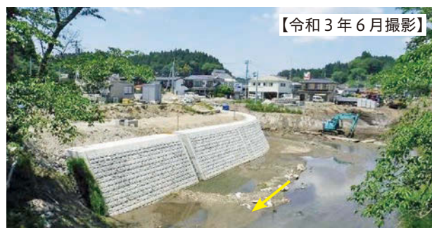
車川合流付近の施工状況
