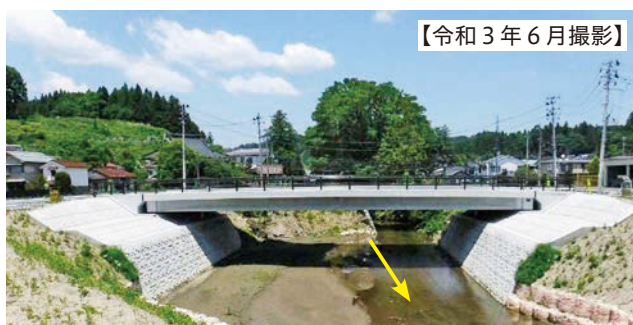
小野橋橋梁下部工・上部工竣工
