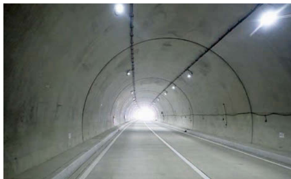
1号トンネルの整備状況 早期完了に向け工事を実施中
