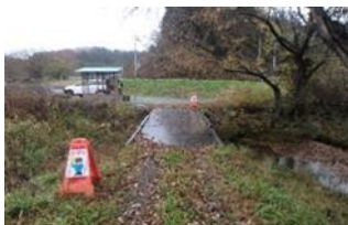
起点側から撮影
