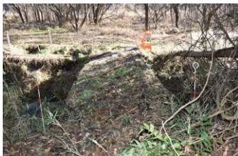
起点側から撮影
