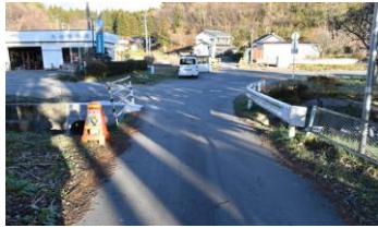
起点側から撮影
