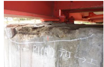
下部工の鉄筋露出(Ⅱ)
