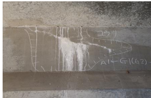
主桁側面の遊離石灰、斜め方向ひびわれ
