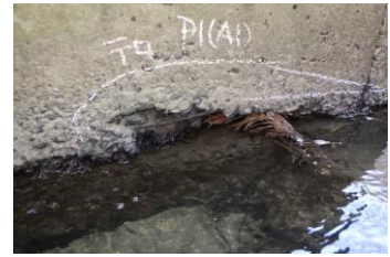
下部工の鉄筋露出(Ⅱ)
