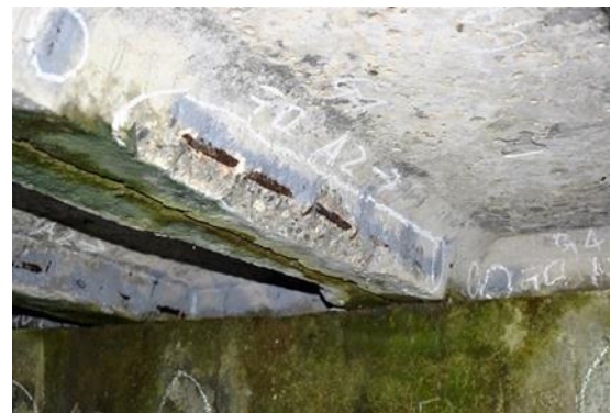
主桁の鉄筋露出
