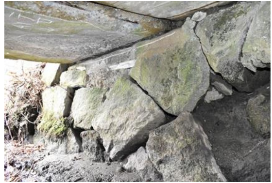
橋台石積の崩落、ずれ
