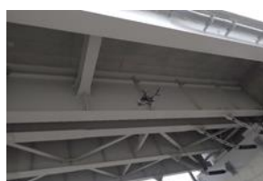
ドローンによる桁下の点検
