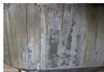
下部工のひびわれ・遊離石灰（Ⅱ）
