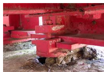
支承の沓座モルタル欠損、 ボルトゆるみ（Ⅲ）
