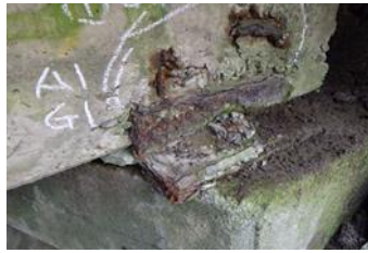
主桁の鉄筋露出(Ⅱ)、 支承の腐食(Ⅲ)
