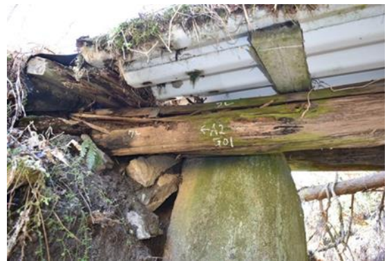
桁端部の木部材の腐朽
