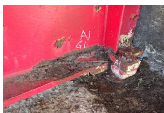
主桁の腐食（Ⅱ）
