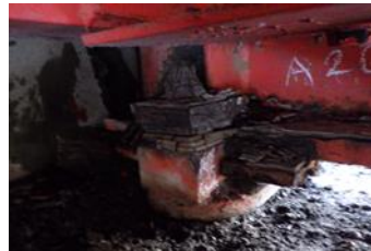
主桁の腐食(Ⅱ)、 支承の腐食(Ⅲ)
