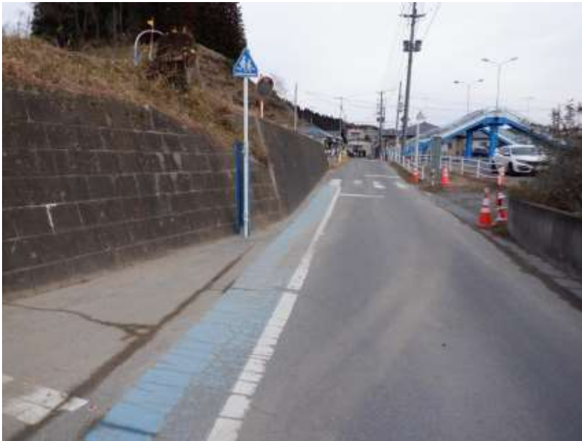
敷地南西側の拡幅予定道路 正面が県道小野四倉線の歩道橋
