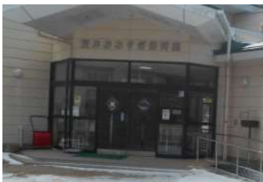
分館入口を見る。
