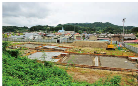
基礎コンクリート打設中
