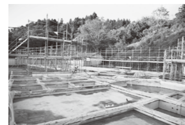
木造軸組土台設置完了
