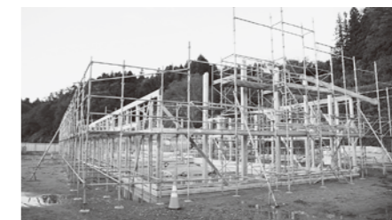
木造建方作業の様子
