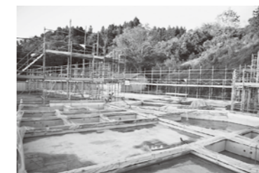
木造軸組土台設置完了
