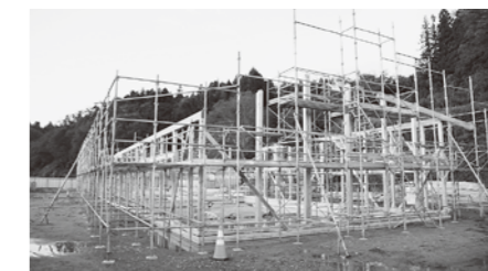
木造建方作業の様子
