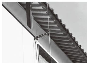
外部アンテナ
