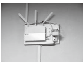
設置されたWi-Fiルーター
