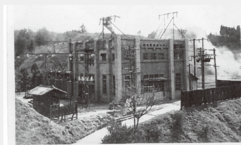
昭和28年頃の小野新町変電所
