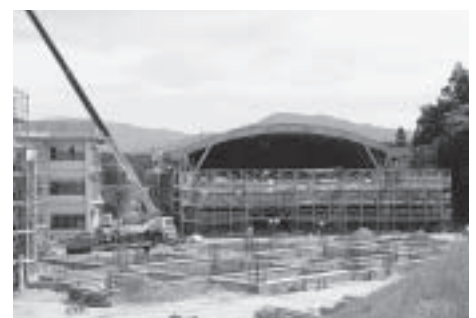
屋内運動場改築工事の状況
