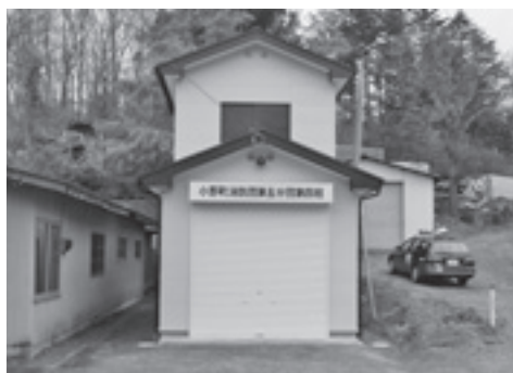
浮金ポンプ置場
