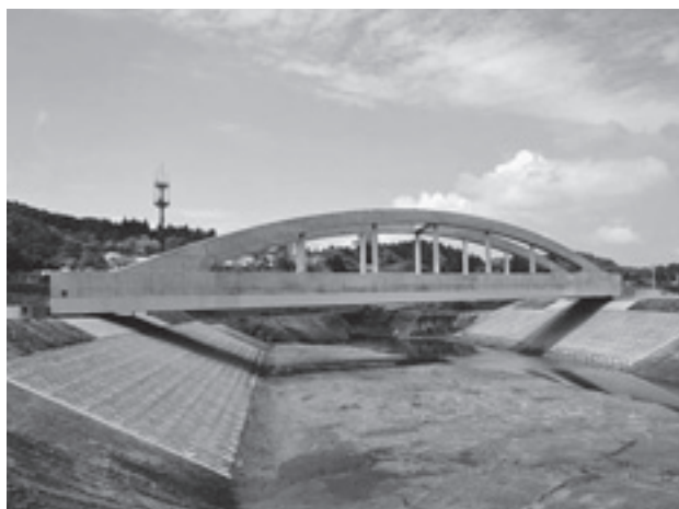
完成したJR橋
