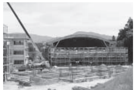
屋内運動場改築工事の状況
