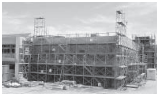
校舎改築工事の状況
