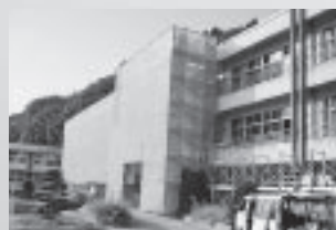
耐震補強工事が完了した飯豊小学校屋内運動場(上)と工事中の小野新町小学校(下)
