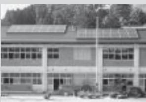
太陽光発電設備工事が完了した夏井第一小学校(上)と浮金中学校(下)
