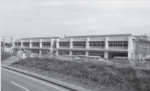
完成間近の普通教室棟
