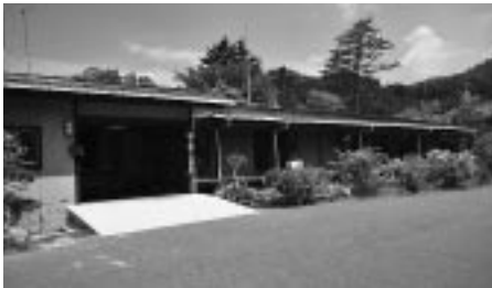
修繕工事が完了した老人憩の家「ゆ〜ゆ〜こまち」
