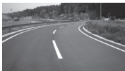
整備が進む七生根線
