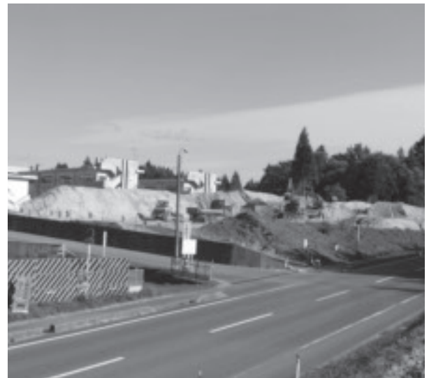
整備が進む小野中学校改築(造成工事)
